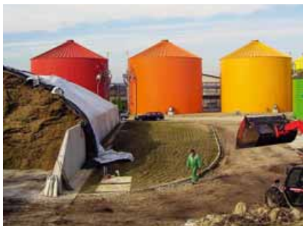
Moderno impianto di biogas
